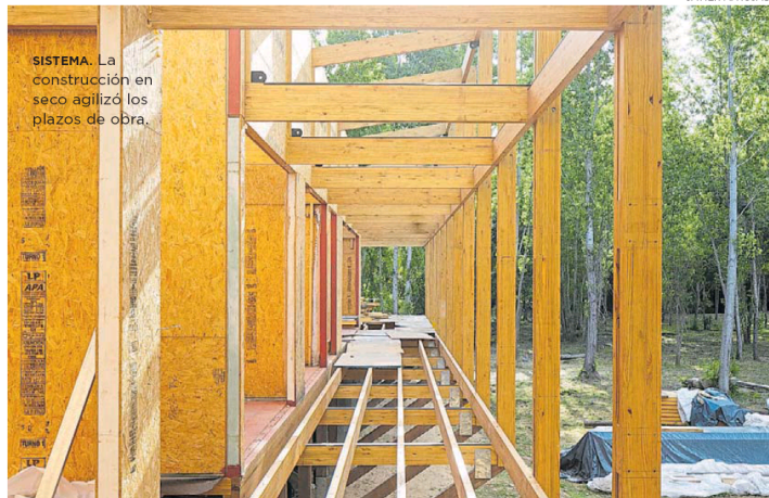
ESTRUCTURA. Piezas de madera laminada de reforestación.
