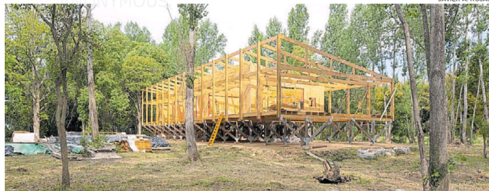
ESTRUCTURA. Piezas de madera laminada de reforestación.
