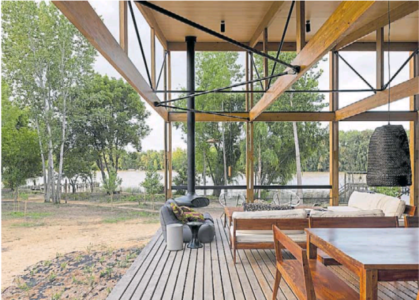
A LA VISTA. Un sistema de arriostres metálicos refuerzan la estructura.
