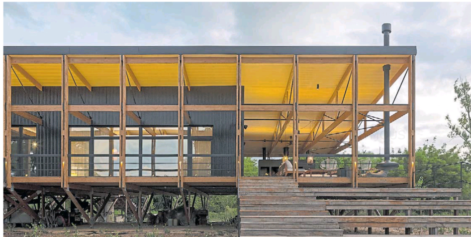
AUTOSUFICIENTE. La hermeticidad de la envolvente se estudió al detalle para reducir al mínimo la transferencia de calor.
